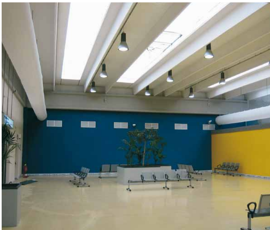
Canale circolare in tessuto. Negozio giocattoli. Circular textile duct. Toys shop.
