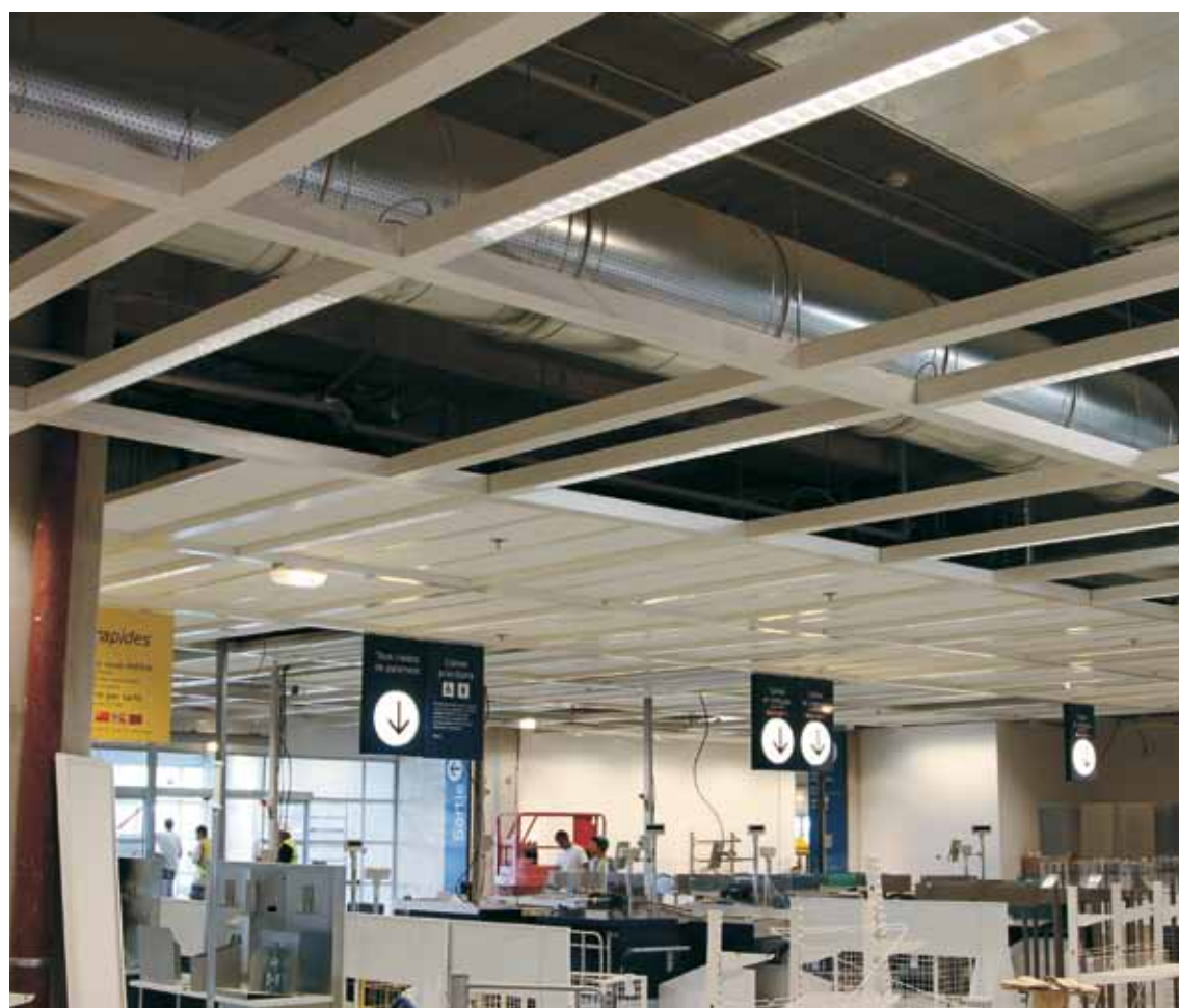
Canale circolare in tessuto. Show room abbigliamento. Circular textile duct. Cloths show room.
