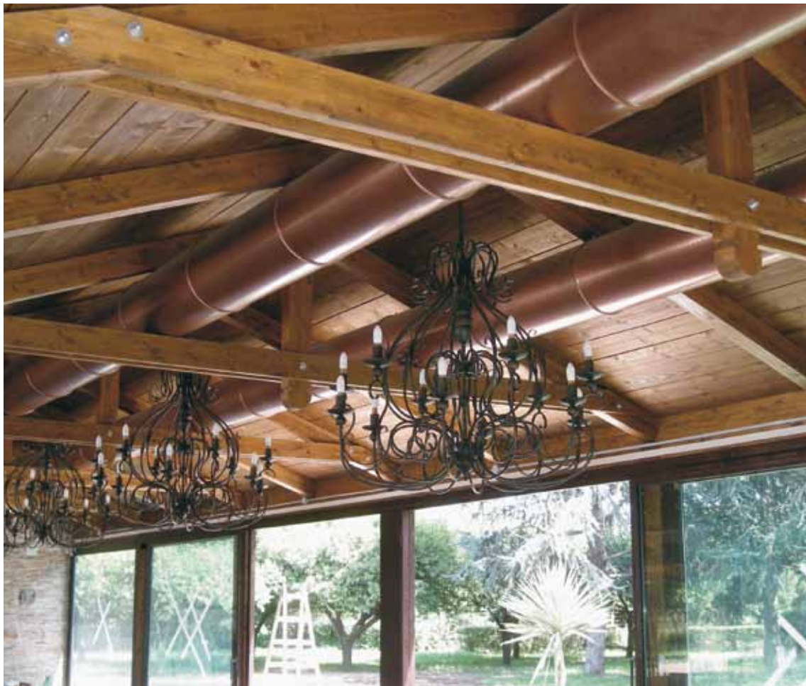
Canale circolare in metallo. Ristorante. Circular metal duct. Restaurant.
