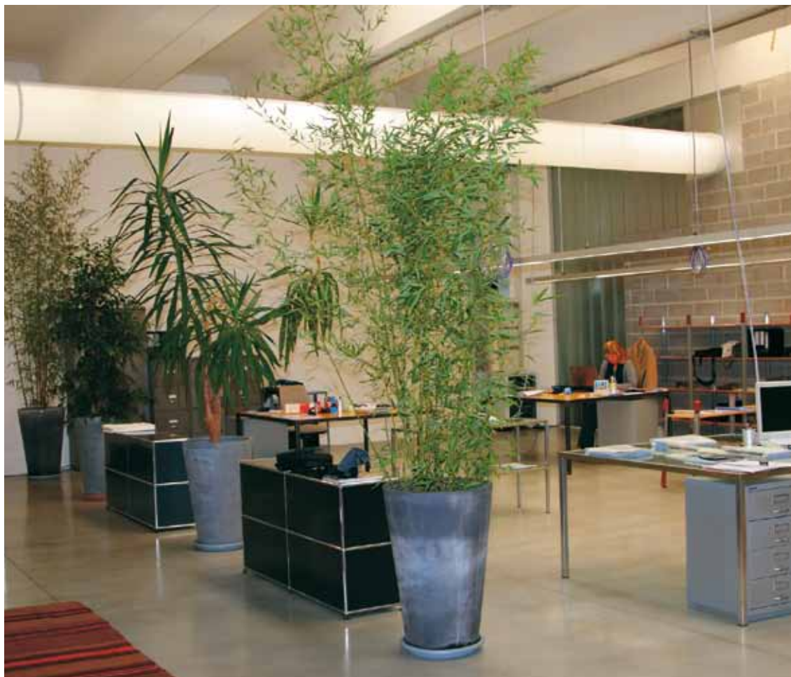
Canale circolare in tessuto. Show room abbigliamento. Circular textile duct. Cloths show room.
