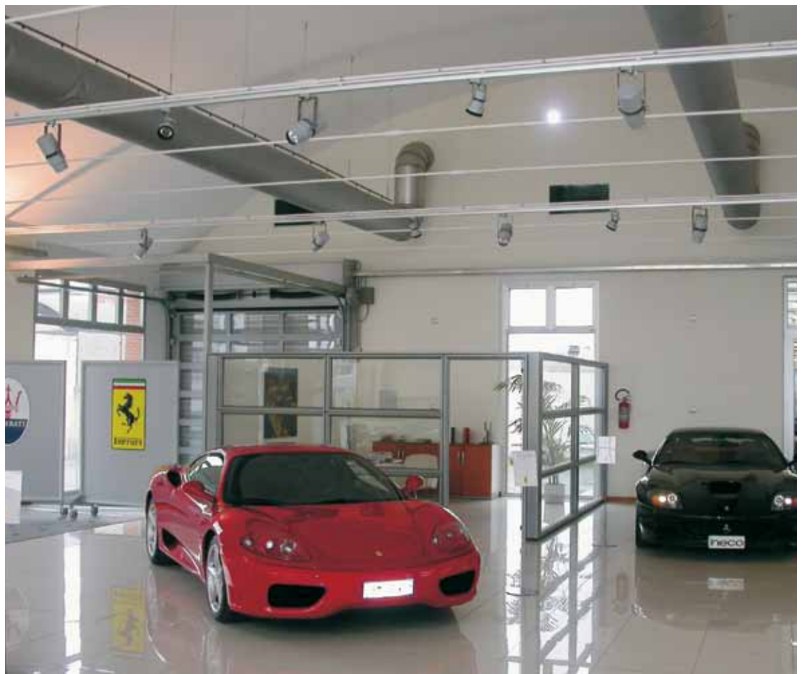
Canale circolare in tessuto. Concessionaria auto. Circular textile duct. Car shop.
