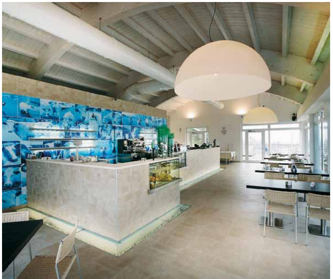
Canale circolare in metallo. Bar ristorante. Circular metal duct. Bar restaurant.
