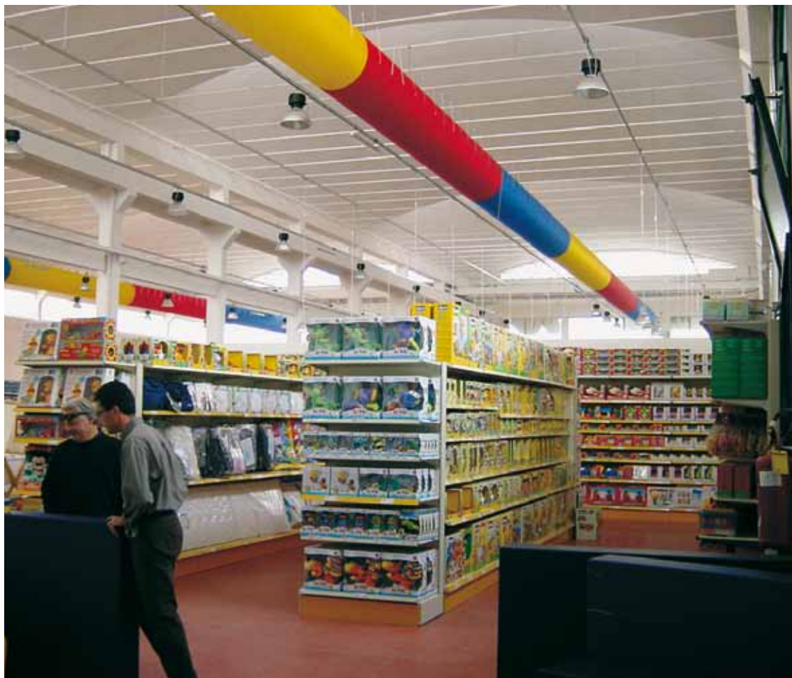
Canale circolare in tessuto. Negozio giocattoli. Circular textile duct. Toys shop.
