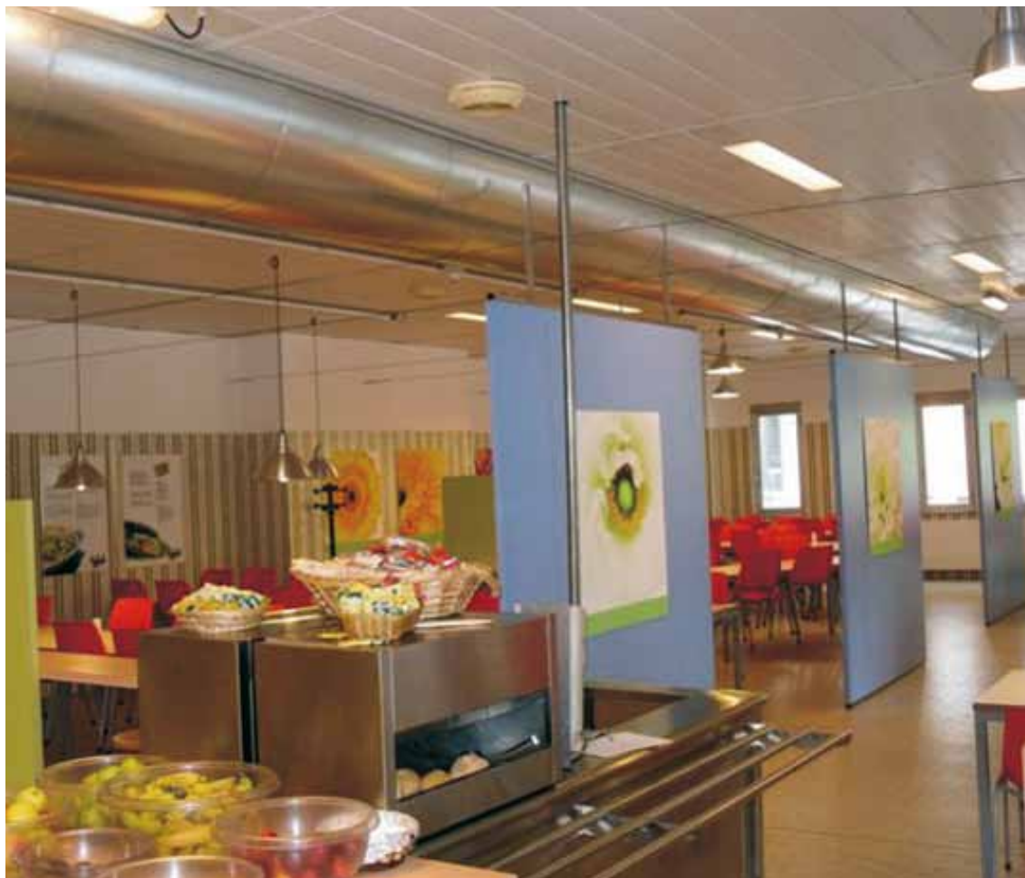
Canale semicircolare in metallo. Mensa aziendale. Semicircular metal duct. Company catering.
